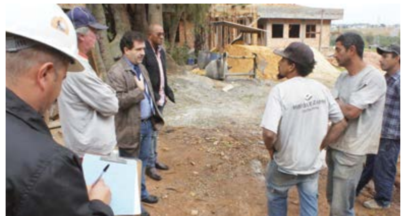
Gelson Santana leva o secretário do Trabalho, Pompeo de Mattos, para ver os problemas em obra da prefeitura
